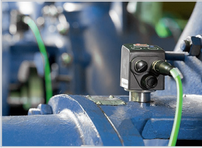
FAG SmartCheck im Einsatz an einer Pumpe
